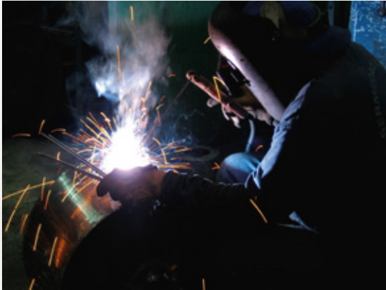
Proceso de Soldadura Eléctrica
