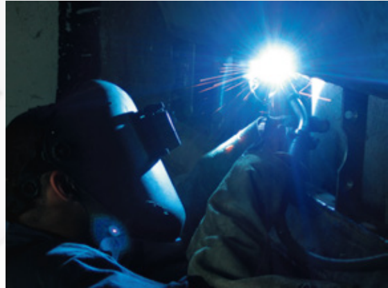
Proceso de Soldadura TIG
